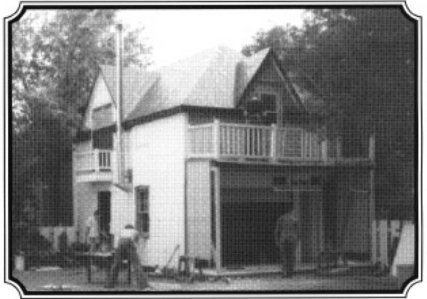
Lorsque le zendo devint habitable, on s'attaqua aux murs extérieurs. La porte de garage fut enlevée, l'ouverture de l'entrée déplacée sur le côté et des portes-fenêtres posées là où sont les vestiaires. Remarquez la cheminée et le petit balcon qui n'existent plus maintenant. Il n'y avait pas de portique dans la bâtisse d'origine.
