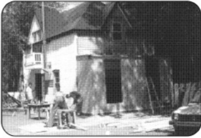
Lorsque le zendo devint habitable, on s'attaqua aux murs extérieurs. La porte de garage fut enlevée, l'ouverture de l'entrée déplacée sur le côté et des portes-fenêtres posées là où sont les vestiaires. Remarquez la cheminée et le petit balcon qui n'existent plus maintenant. Il n'y avait pas de portique dans la bâtisse d'origine.
